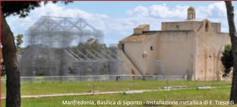
Manfredonia, Basilica di Siponto - Installazione metallica di E. Tresoldi
